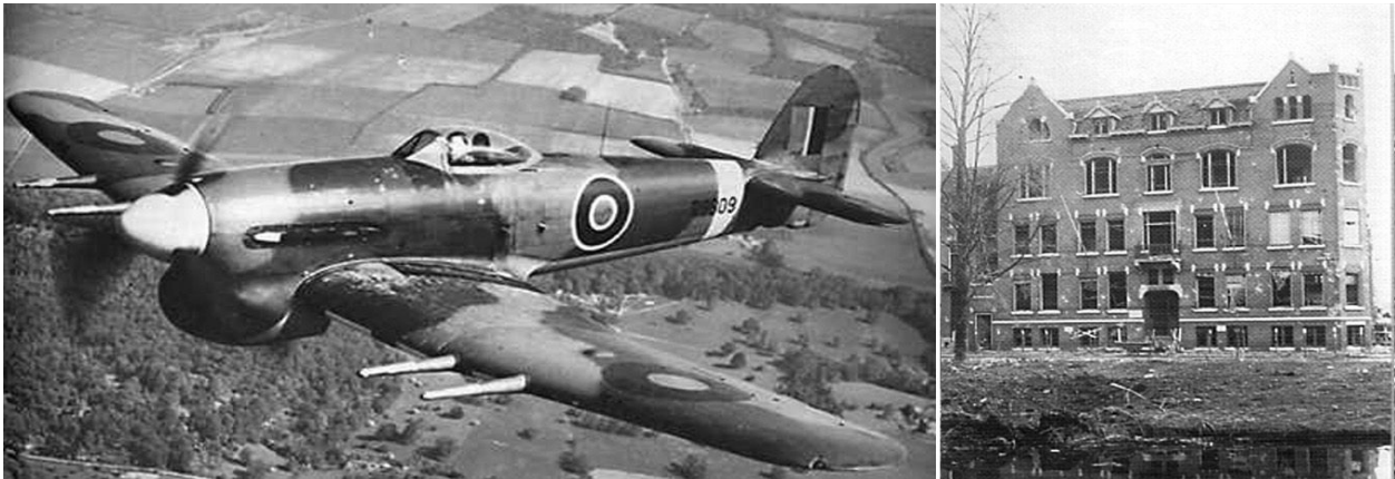
Hawker Typhoon jachtbommenwerper - Het gebouw van de SD na de aanval
